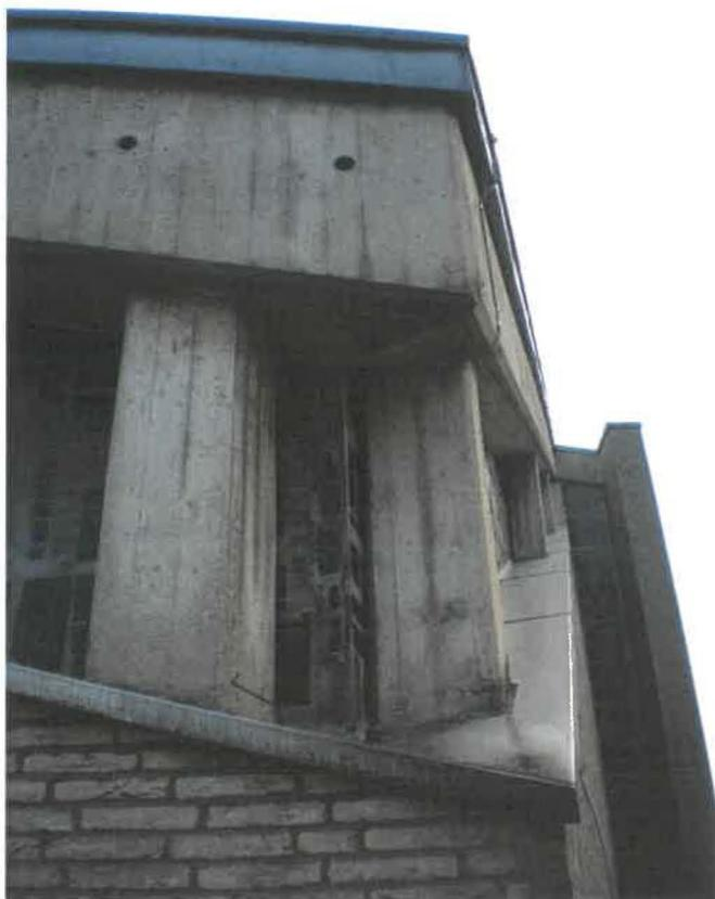
*Abb. 19: Detail an der S/W-Ecke; die tragende Betonstruktur ist ausgemauert und mit hellgrauem Backstein verkleidet, tritt teilweise als zweite Wandschicht in Erscheinung und gibt den Blick auf das Glasstahlbetonband als dritte Wandschicht frei.*
