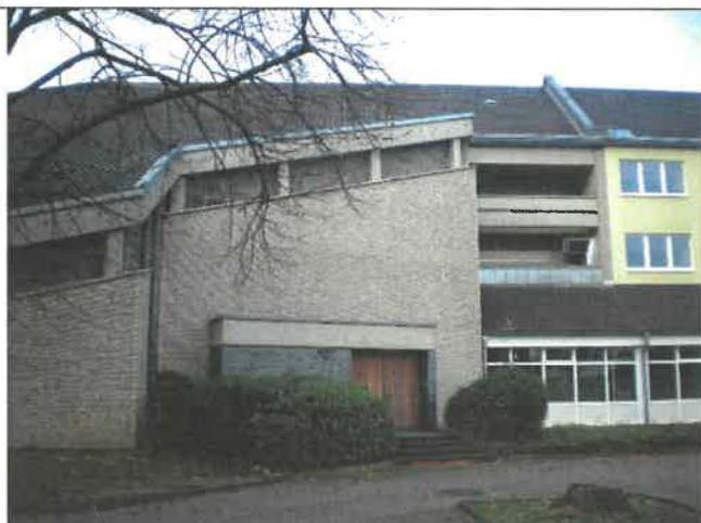
*Abb. 17: Ostseite mit Eingang; die Anschluss-stelle an den Aulatrakt im EG mit vorgesetzter Verglasung (Gang).*
