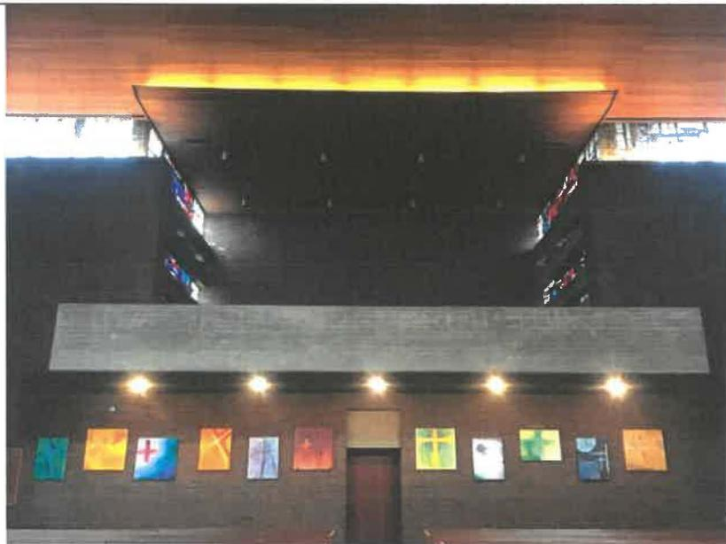
*Abb. 21: Blick auf die Empore im Nordarm, mit Betonbrüstung und der in den Raum vorkragenden, Holzverkleideten Deckenzunge.*
