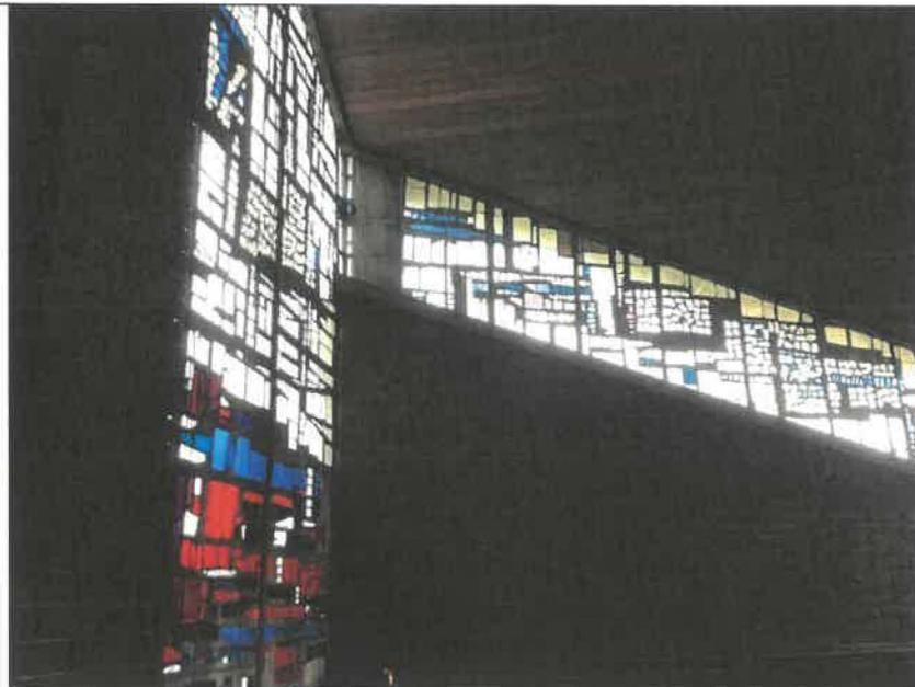
*Abb. 29: Betonung der Raumecken durch das durchgezogene Glasstahlbetonband, optische Trennung von Wand und Decke zur Verstärkung von deren schwebendem Eindruck.*
