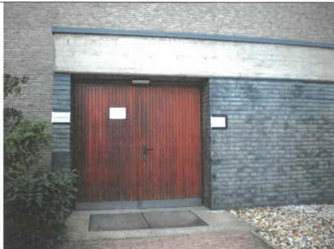
*Abb. 14. Westeingang; der Bauteil ist formal dem Windfang und den Beichtstühlen im Inneren zugehörig und zeigt denselben kräftigen Betonabschluss; Schieferverkleidung.*
