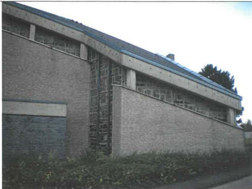
*Abb. 13: Westseite; markant das Motiv der mit dem Glasstahlbetonband verbundenen Wandscheiben.*
