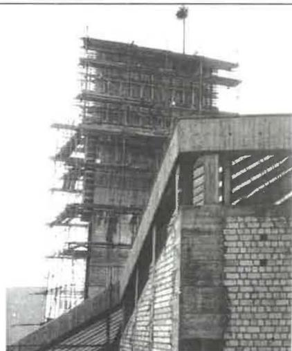
*Abb. 11: Richtfest am Turm; wohl 1971. I Vordergrund die Betonstruktur mit Ausmauerung erkennbar, vor der Einbringung des Glasstahlbetonbandes. Foto aus: Heuel 2016, S. 47.*
