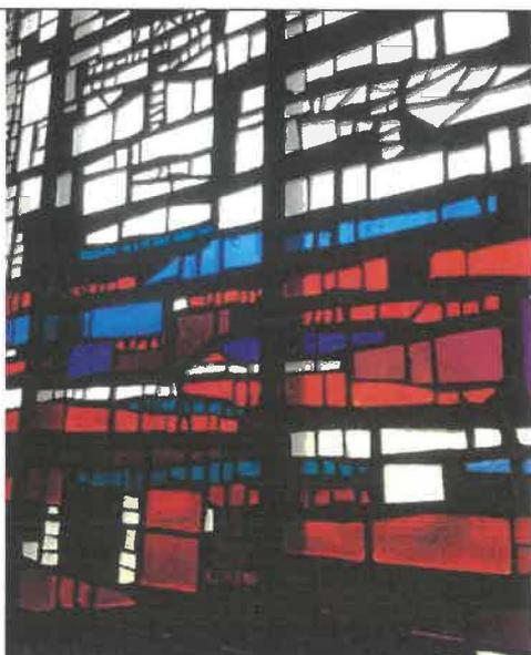
Abb. 28: Detail der Glasstahlbetongestaltung, deren rechteckige Felderung sich aus Metallrahmen ergibt.
