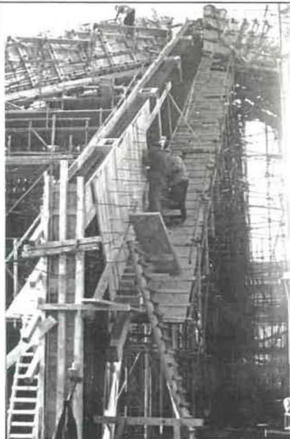
*Abb. 10: Bauarbeiten, um 1971; gut erkennbar das Beontragewerk des Kirchenraums. Foto aus: Heuel 2016, S. 46.*
