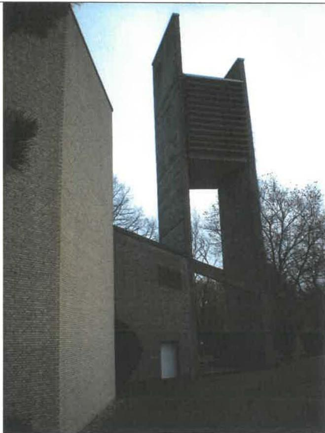
*Abb. 18: Der aus zwei Wandscheiben mit verbindender Glockenstube (Betonlamellen) gebildete Glockenturm wird mit dem Hauptbaukörper ästhetisch durch die Betonträger verklammert.*
