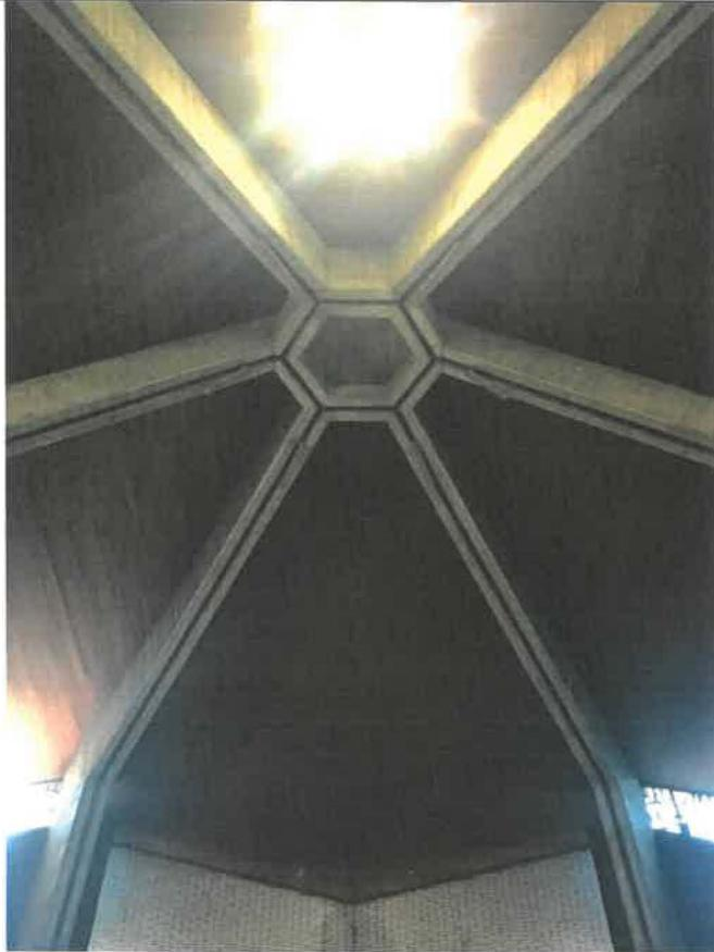
*Abb. 32: Schlusssteinartiger, sechseckiger Ring als Hochpunkt des Zeltdachs, in dem die Betonträger zusammenlaufen.*
