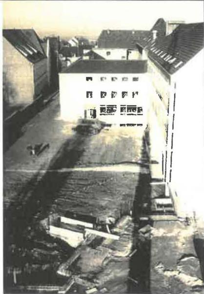
*Abb. 9: Bauarbeiten, um 1968/690, im Vordergrund der Kirchengrundriss angeschnitten, rechts mittig die Anschlussstelle zum Aulatrakt. Foto aus: Heuel 2016, S. 46.*
